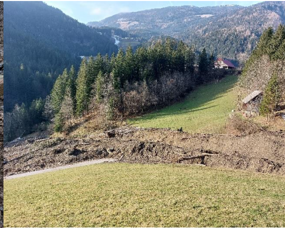
Slika 6: Pogled na potencialni akumulacijski prostor na območju prve izravnave/travnika pod plazom, pregrupiranje trenutno akumuliranega materiala je bilo izvedeno v sklopu interventnega zakona. Nujno potrebna ureditev prebiralne pregrade in struge potoka
